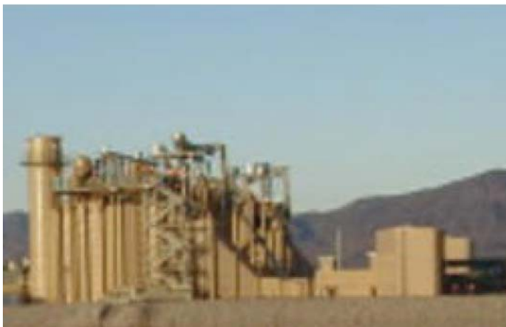
Figure 12: HRSG Plant in Western U.S.
