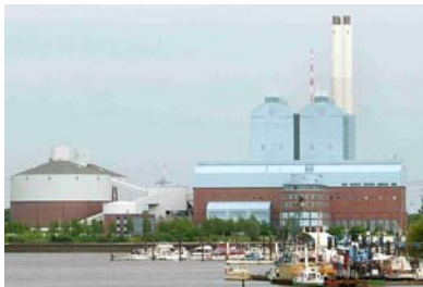
HEW's Tiefstack Cogeneration Plant
